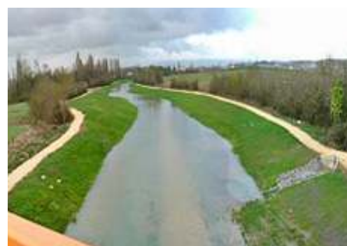
Foto. Cauce de avenidas en el río Zadorra (tramo Eskalmendi-Gamarra).
