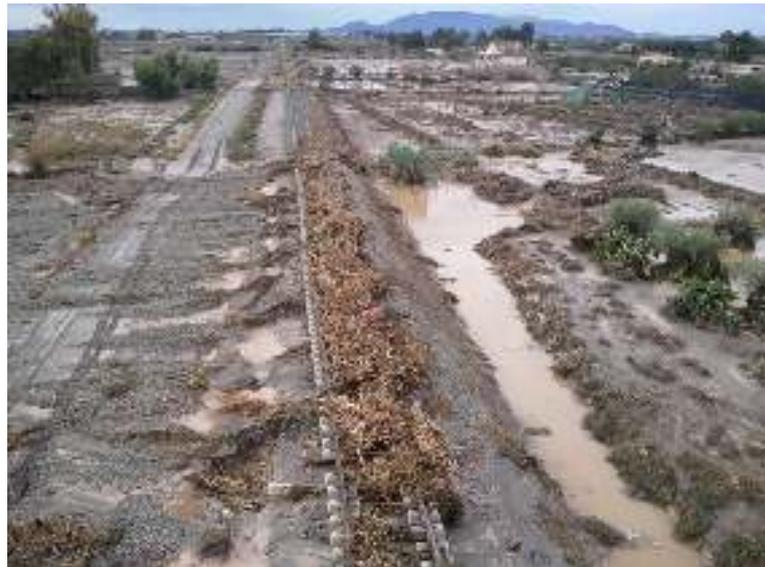
Suspensión del tráfico ferroviario entre Lorca y Águilas (Murcia) tras el paso de un temporal, provocando el colapso de las obras de desagüe, descalce de la vía y arrastre de taludes de terraplén.
