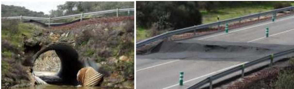
Hundimiento y derrumbe de parte de la calzada como consecuencia de la caída de un paso inferior en la carretera N-420 a la altura de Fuenaliente (Ciudad Real), debido a las fuertes lluvias.
